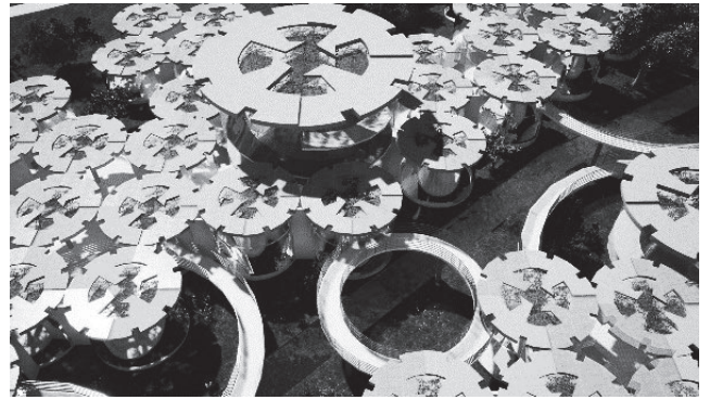
写真2 円形ユニットから成る施設
