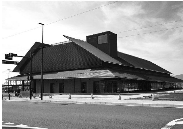
写真3 建設中の新陸前高田市立博物館
